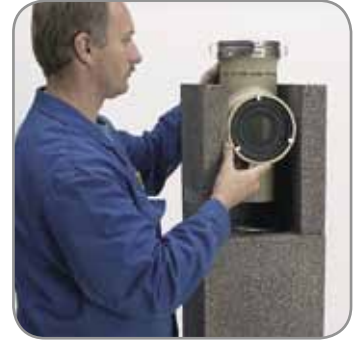
4.8 Tegyük a helyére a füstcső-csatlakozó elemet.
