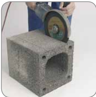
I.5 A vizsgáló ajtó nyílását kivágjuk. (kivágási szélesség: 16 cm)
