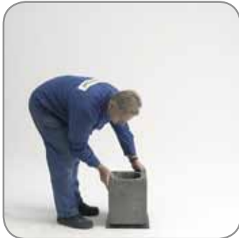
I.1 Az első köpenytéglát javított falazó mészhabarcsba elhelyezzük.
