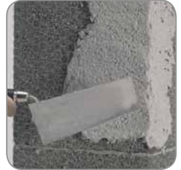
6.4 A vakolat gondos felhordá-sával előzzük meg a kapcsolódó falak melletti vakolatrepedé-seket.
