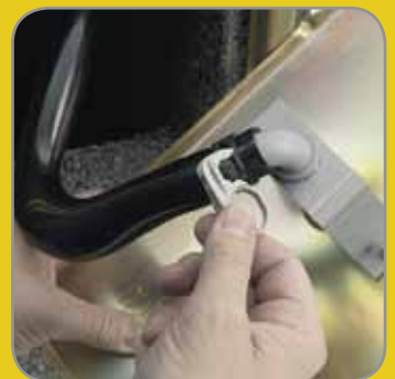
I.12 Tegyük vissza a könyökcövet az előtét lemezen kialakított helyére, és a szorító gyűrűt húzzuk le.
