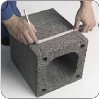
4.5 Jelöljük be a csatlakozó kivágási méreteit a köpeny-téglán. A kivágás szélességét lásd a 4. oldalon
