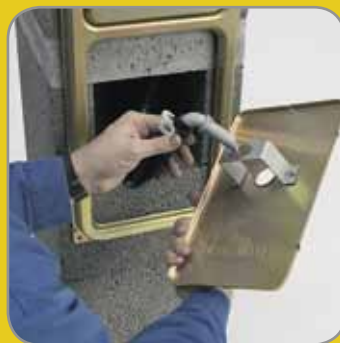
I.11 A szorító gyűrűs szifoncsövet húzzuk rá a kifolyó könyökre, és tekerjük a kifolyás irányába.
