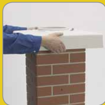
8.3 A fedlapot habarcságyba ül-tessük.
