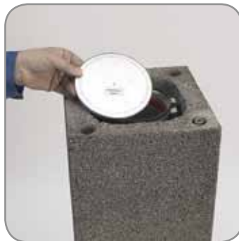
5.2 A védősapkát helyezzük a csőre.
