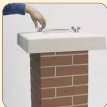
9.7 ... és átlósan csavarozzuk a kéményfejhez.
