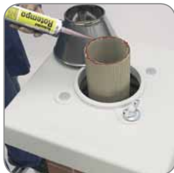
8.7 A csövet ragasszuk a helyére, a sima vége álljon felfelé. Hordjunk fel a peremére bőségesen ROTEMPO-t.
