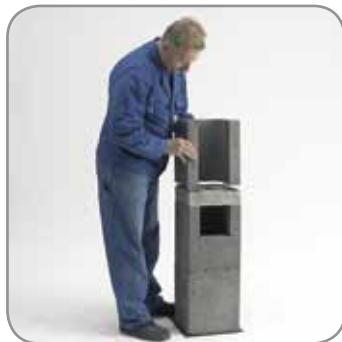
I.6 A kivágott köpenytéglát a lábazati lapra felhordott habarcsra helyezzük.
