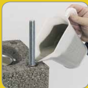
8.2 A sarokfuratokba a megke-vert kiöntő habarcsot öntsük bele. Ügyeljünk arra, hogy a vas a kiöntés után is központosan helyezkedjen el lyukban.
