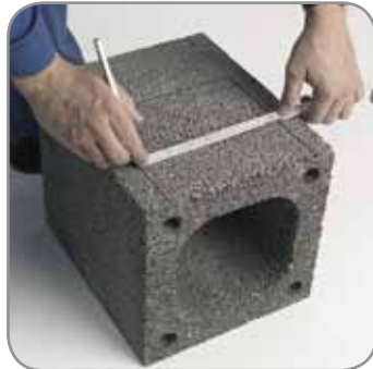
I.2 A kondenzvíz kivezetési nyílását a köpenytéglára berajzoljuk (16 x 16 cm) és a nyílást kivágjuk.
