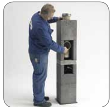
I.8 A vizsgáló nyílással ellátott bordázott samottcsövet központosan a beton lábazati lapra, habarcsba elhelyezzük. A szifont a helyére illesztjük és a bordázott samottcső felső peremére ROTEMPO-t nyomunk.
