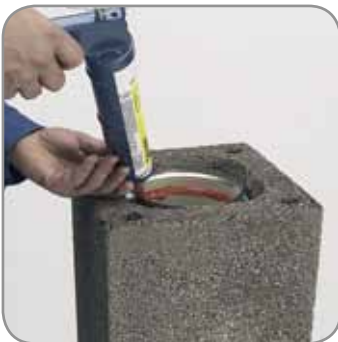
5.1 Schiedel ROTEMPO-val alaposan bekenjük a profil samottcső peremét. Előtte a samottcsővek csővégeit pormentesítsük. A hézag-tömítő masszát mindig a profil cső felső végére (tömítő-központosító gyűrűs vég) kell felhordani.
