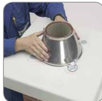
8.8 A torkolati kúpot helyezzük rá szintbe állítva. A kitüremkedő masszát a hézaglehúzóval húzzuk le.
