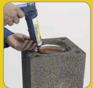
5.8 ROTEMPO-t nyomunk vastagon a profil cső peremére, helyezzük a védősapkát. Ezt az építési folyamatot a kéménytorkolatig folytatjuk.
