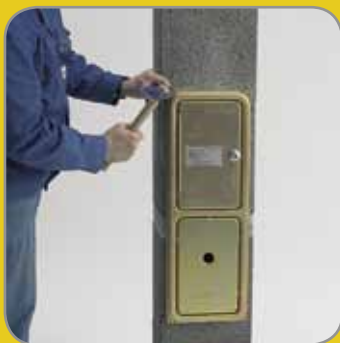
I.9 A lábazati fedőlemezt a nyílás elé rögzítjük.
