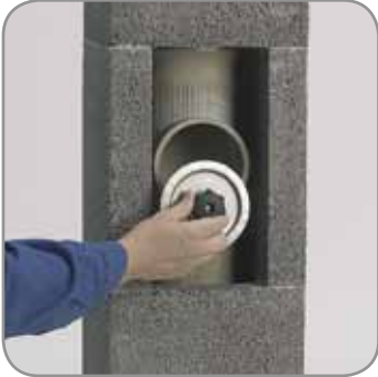
6.1 Helyezzük fel a vizsgáloní-lás fedelét.
