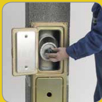
I.10 A vizsgáló nyílás fedelét behelyezzük.
